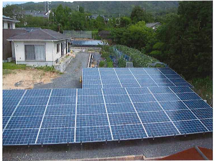
太陽光発電設備 24.08kw
