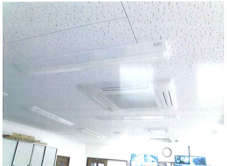
省エネエアコン及び照明LED化
