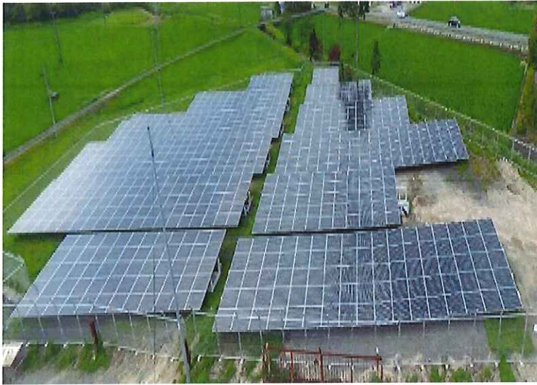
太陽光発電設備 24.08kw
