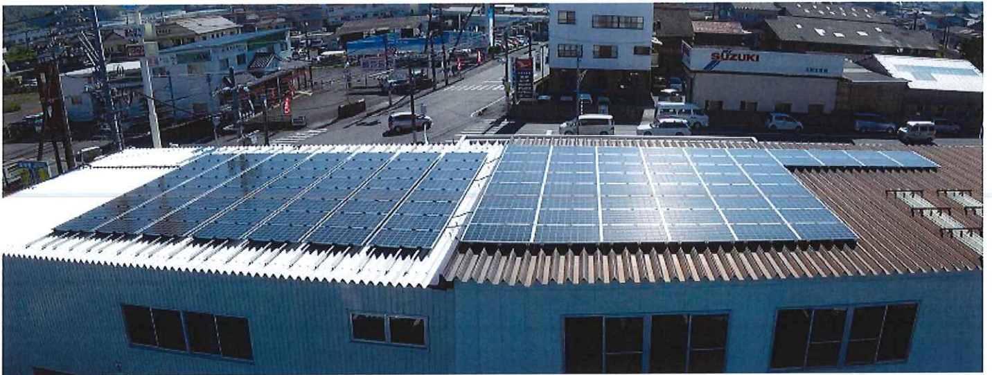
太陽光発電設備 24.08kw
