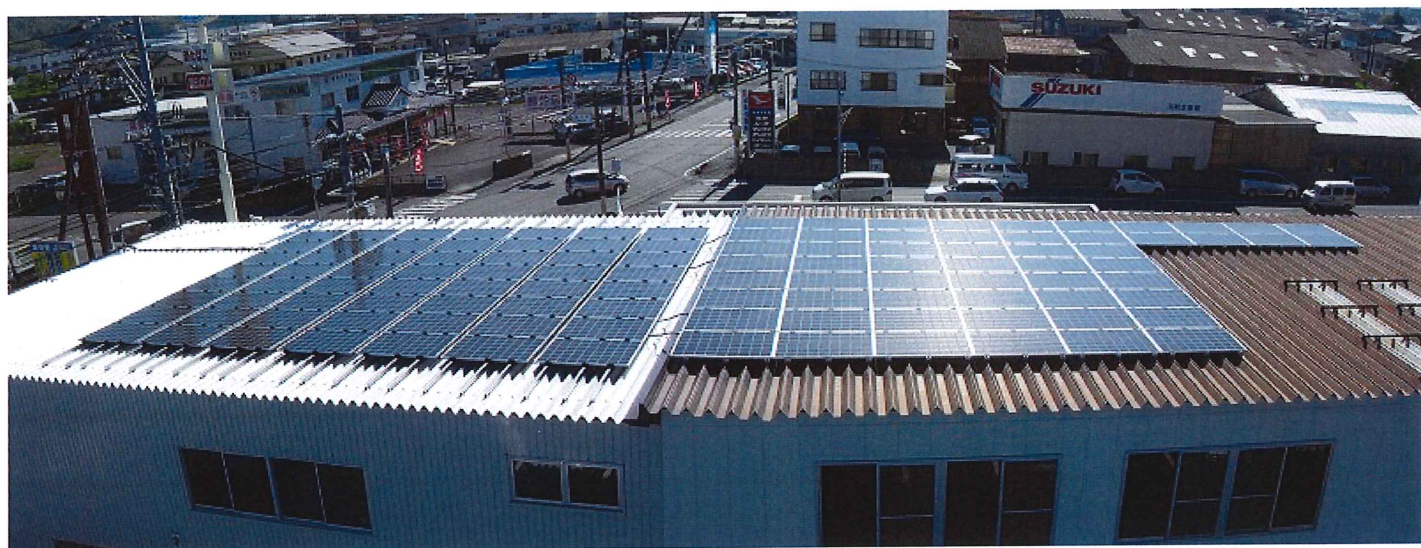
太陽光発電設備 24.08kw
