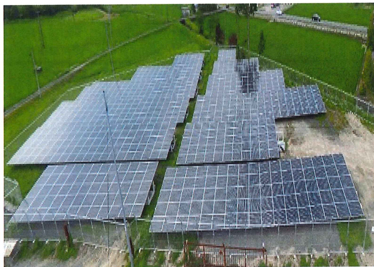
太陽光発電設備 24.08kw
