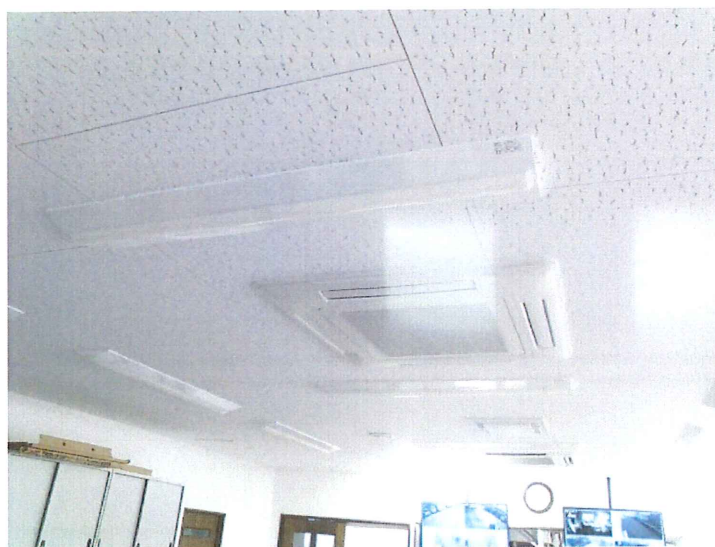
省エネエアコン及び照明LED化
